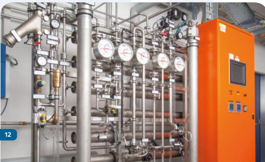
Wasseraufbereitung für die Hämodialyse
