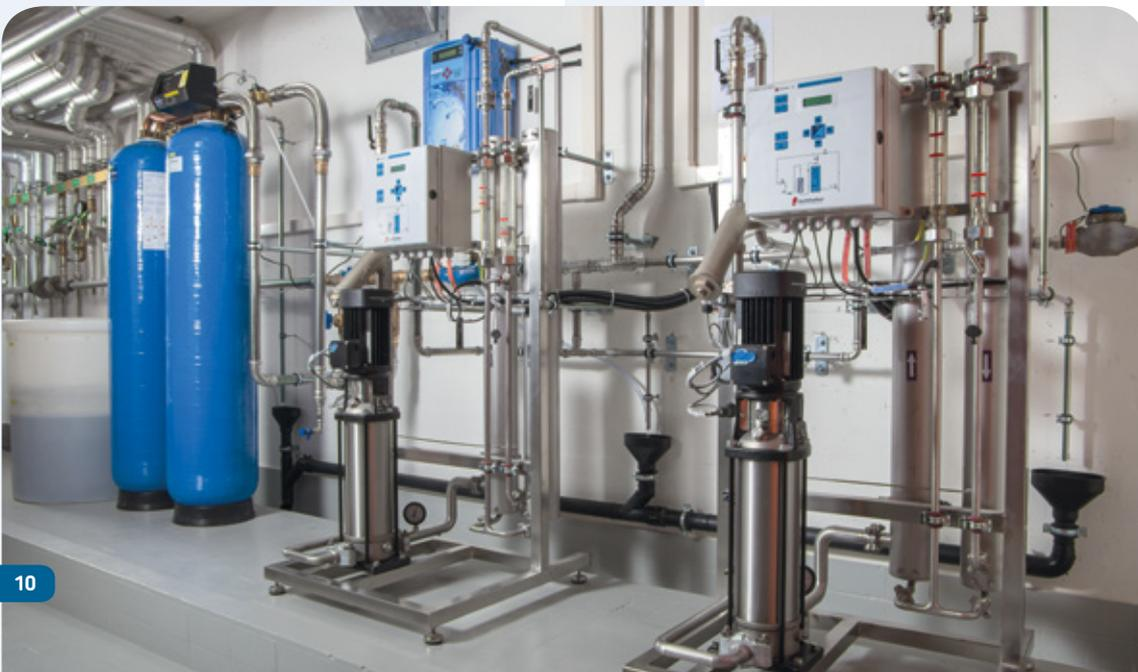
Typische Gebäudewasseraufbereitung mit Enthärtung und Umkehrosmose
